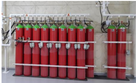
ระบบดับเพลิง
